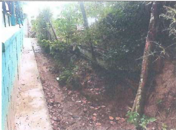
Foto 3: MEJORAMIENTO DE CERCO DETERIORADO
